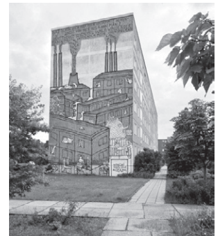
Hochhaus »Malplatte« Kulturfabrik Hoyerswerda e. V.
