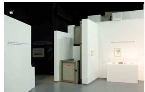
Abb. 2: „Georg Büchner. Revolutionär mit Feder und Skalpell“, Mathildehöhe Darmstadt, Hubbühnen parallel zu Treppe in Ausstellungsarchitektur integriert, Projektbegleitung Barrierefreiheit CBF Darmstadt: (Foto: Michael Müller)
