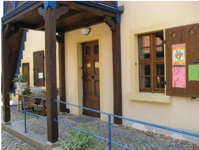
Abbildung 3 Schwellenloser Eingang zum Haupthaus
