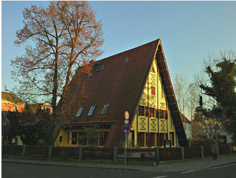
Abbildung 1 Das Putjatinhaus von der Straße aus gesehen.
